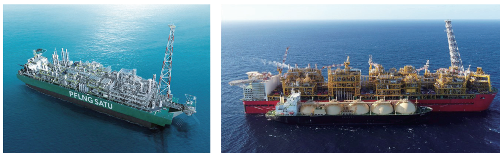
图9 已投用的两艘浮式LNG装置
